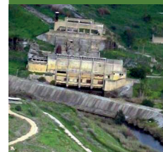
Das Wasserkraftwerk in Naharaim
